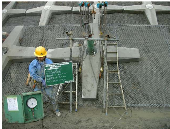
アンカー基本試験
