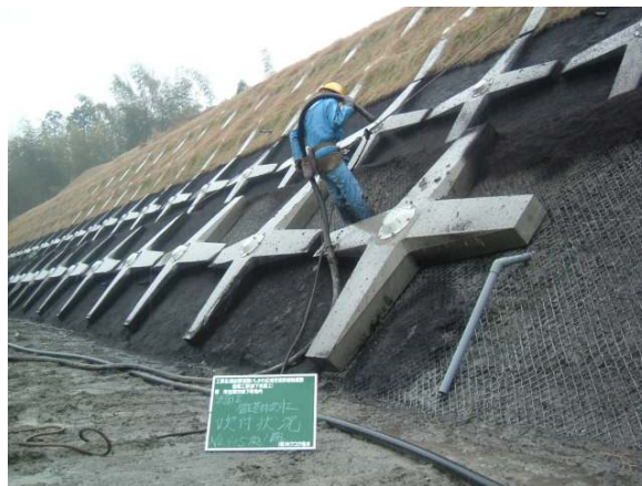
法面工 植生基材吹付
