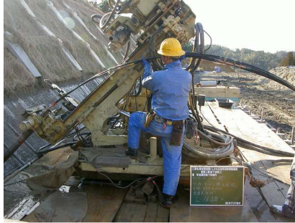
アンカー tendon 挿入
