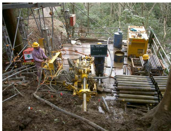
水抜ボーリング工事
